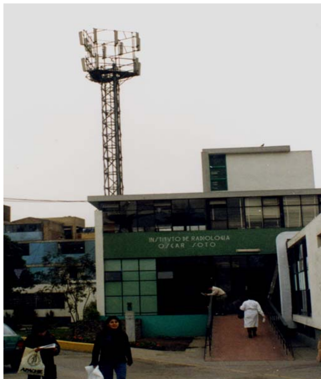
Fig. 8 Estación base instalada sobre el Instituto de Radiología Oscar Soto Hospital Arzobispo Loayza en Lima
