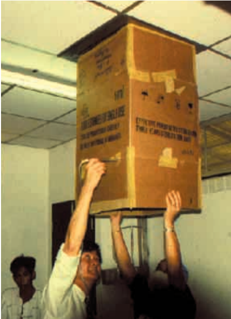
Caja de cartón y medidor de la velocidad de flujo para vigilar el flujo de aire en el cuarto de aislamiento de pacientes tuberculosos con sistema de ventilación mecánica, Hospital de Rai Chiang, Rai de Chiang, Tailandia
