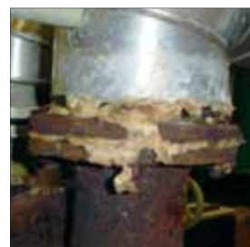
Tuberías de agua
